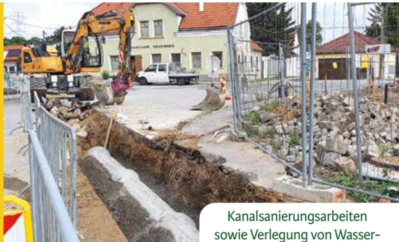
Kanalsanierungsarbeiten sowie Verlegung von Wasser- und Stromanschluss im Kreuzungsbereich Königsbrunn
